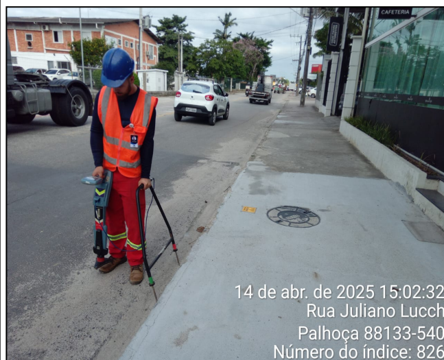
Figura 4 – Inspeção do duto derivação para Ramal Sinasc.
