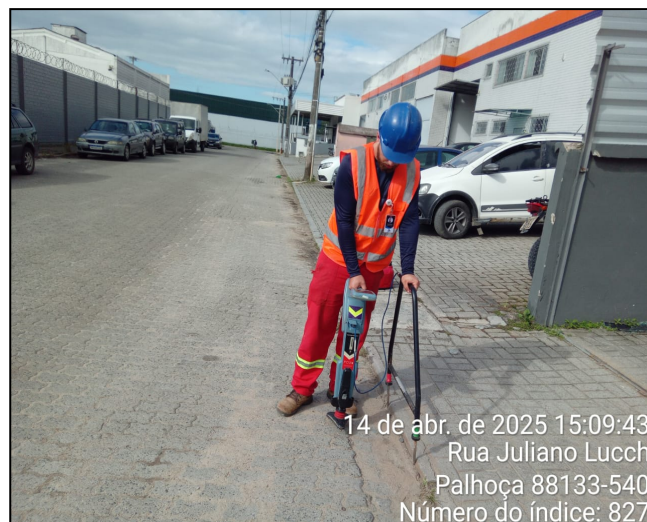
Figura 3 – Inspeção do duto - Linha Tronco Sinasc Ø3”.
